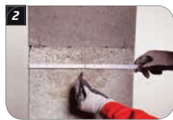
2 Ermittlung der Platzierung des Rauchrohranschlusses.
