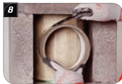
3 Mantelsteinanschnitt anzeichnen.
