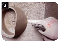
3 Mantelsteinanschnitt anzeichnen.
